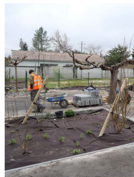
Travaux en cours à Jean Pometan
