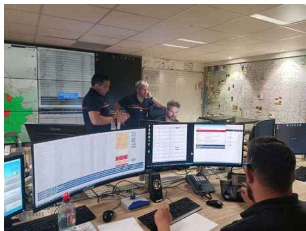
Centre de contrôle
