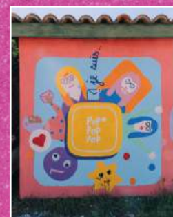
Poste ENEDIS allée des Fleurs
