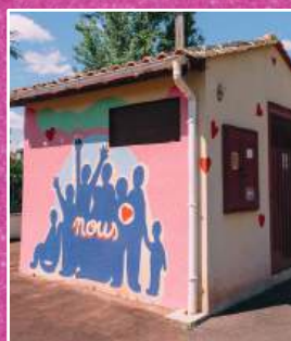
Poste ENEDIS rue Four à chaux
